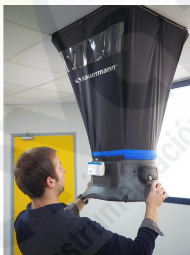
Colocación del caudalímetro
