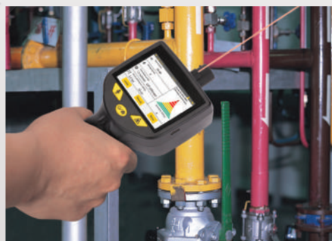
Detección de fugas a distancia con el puntero láser integrado
