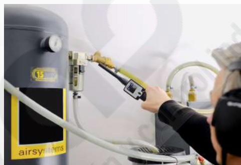
Detección de fugas con tubo de enfoque
